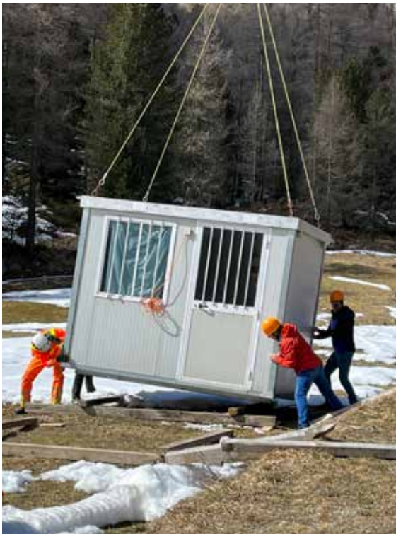
Erste Vorbereitungen für unseren Umbau
